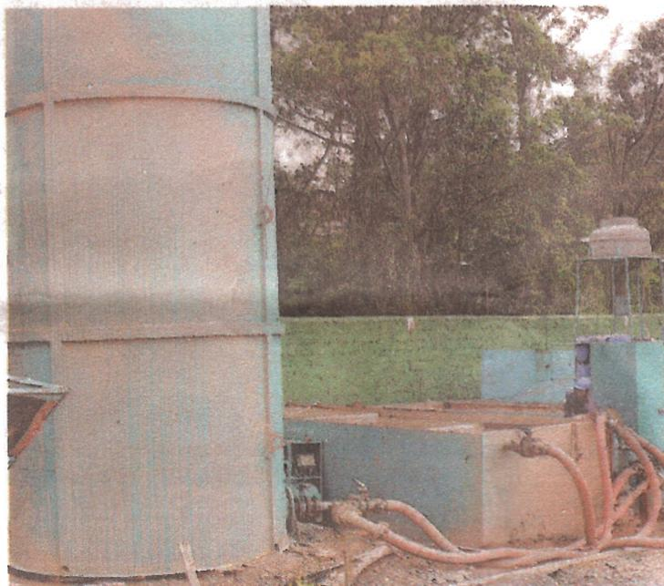
**ECOLÓGICO** - Tonel para armazenamento do polímero (à esquerda), que ocupa o espaço do buraco onde será lançado o concreto e impedindo que a terra se movimente. "O tubo entra no local e vai levando o concreto de baixo para cima, expulsando o polímero que é, então, guardado em tonéis." O material pode ser reutilizado indefinidamente, bastando só ser reavaliado. Em geral, são feitos pequenos ajustes na sua composição.
